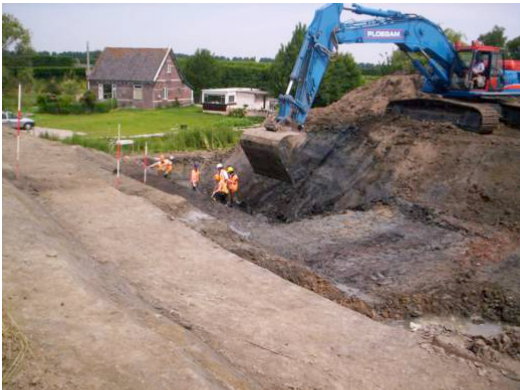
Afb. 5.101 Dit is de eerste archeologische doorgraving van de Zuiderdijk bij het buitendijks land van Wijdenes. Op de foto is een woning te zien die inmiddels door een nieuwe stolp is vervangen. Dit buurtje wordt in de volksmond Nazareth genoemd. Waarom is onduidelijk. De uitvoering van dit archeologisch onderzoek startte in juli 2010.
