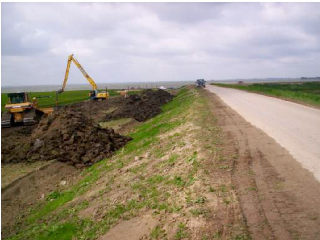
Afb. 5.68 Bij de Kleine Uiterdijk begint men hier de dijk om te leggen en hoger te maken. De bulldozer egaliseert en verdicht de aangevoerde klei.
