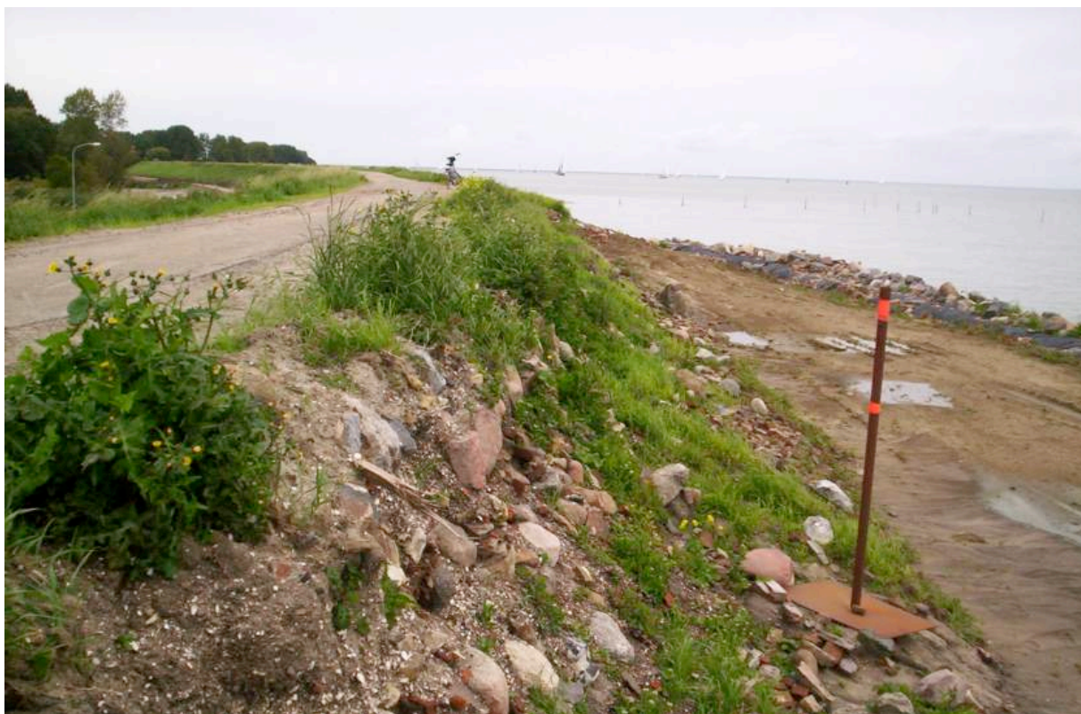
Afb. 5.30 en 5.31 De foto's geven enig inzicht in de samenstelling van de oude dijk bij De Weed. Aan de bovenkant kwamen puin en noordse stenen tevoorschijn nadat de regen de stenen had schoon gespoeld.
