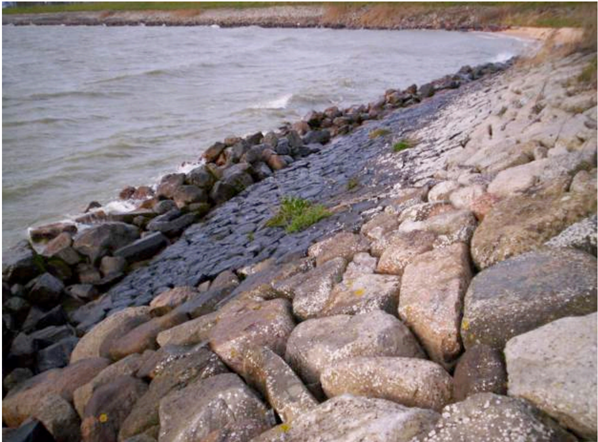
Afb. 3.77 Bij de Appelhoek (dijkdoorbraak) is na de storm van 1916 basalt aangevoerd om de glooiing te herstellen. Zeer duidelijk is het verschil in grote en kleur te zien.
