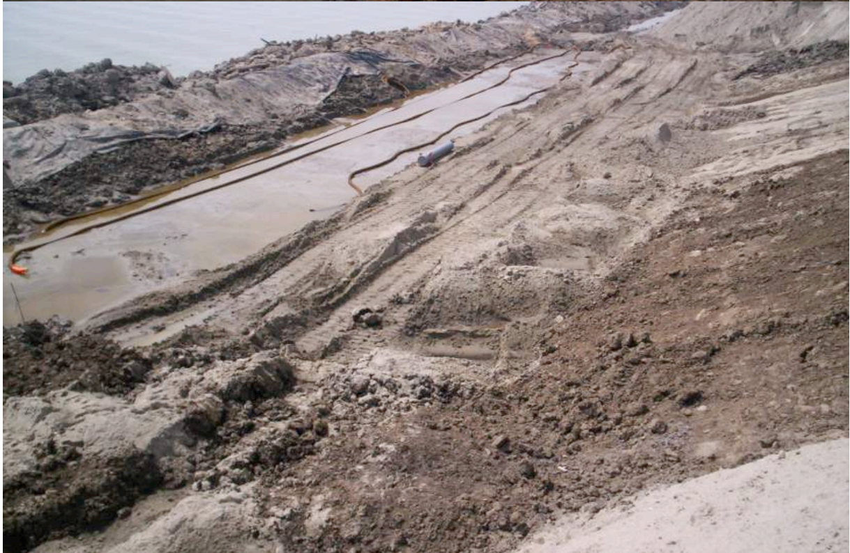
Afb. 5.10 De keileemdijk is nu zover klaar dat de achterliggende grond in gedeelten kan worden droog gepompt. Op de bodem is een drainage aangebracht die op een bemalingsput is aangesloten. Een pomp in de put pompt het water weg, waarna de put met zand wordt aangevuld.
