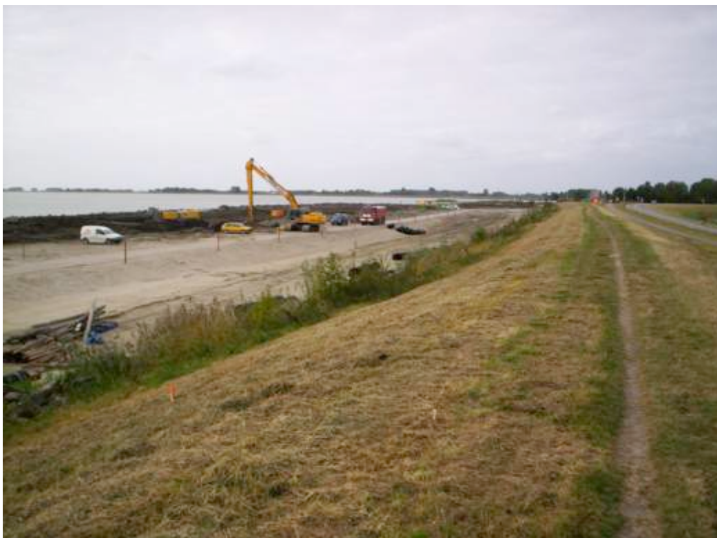
Afb. 5.94 Nadat het zand achter de schanskorven was gespoten werd na enige tijd de buitenkant van het nieuwe land verder afgewerkt met klei en kon het zand worden ontwaterd waardoor het te berijden was met materieel en de uitvoering weer een stap verder kon.
