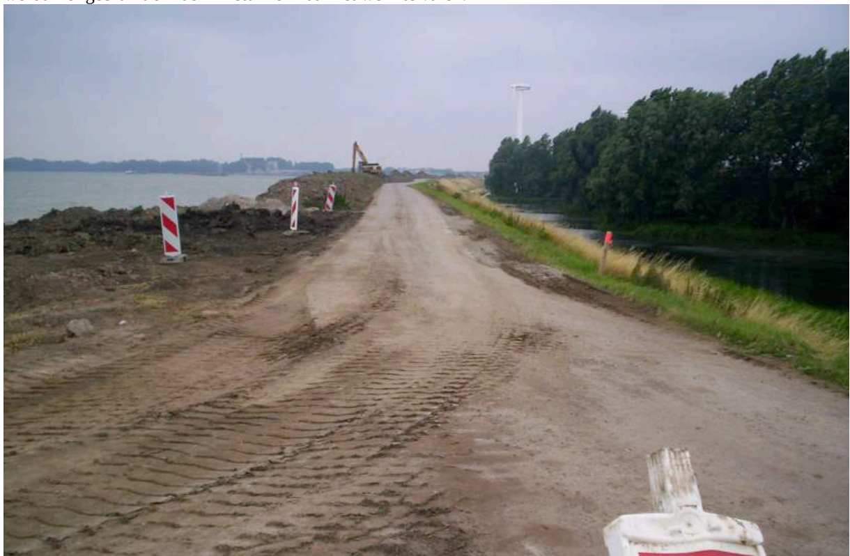
Afb. 5.32 Vanaf de hoek in de Zuiderdijk bij de Kleine Uiterdijk - augustus 2008. Over grote lengte was de nieuwe teen van de dijk klaar.
