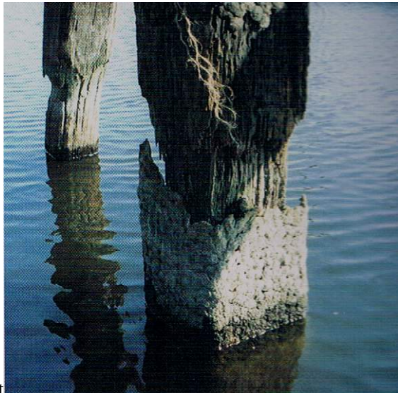
Afb. 3.70 Een paal bedekt met spijkers grote ijzeren koppen. Veel moeite maar de paal is evengoed onderhevig aan houtrot.
