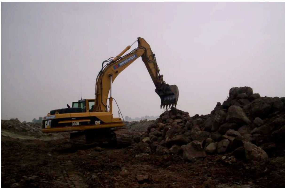
Afb. 5.25 Hier transporteert men de noordse stenen naar de nieuw te maken teen, waardoor de noordse stenen van zetsteen worden gedegradieerd tot stortsteen en nooit meer zijn te zien.
