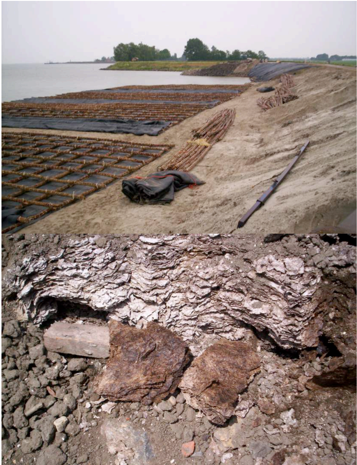
Afb. 5.14 Nadat het puin onder de oude glooiing was verwijderd, kwam de oude wierdijk te voorschijn. Nabij de Spuiter waar ik deze foto heb genomen, waren de palen van de wierdijk niet meer aanwezig. Het wier is hier voornamelijk wit. Dit betekent dat het in zoetwater geoogst is, zoals het bruine wier in brakwater en het zwarte wier in zout water. [toevoeging fe]
