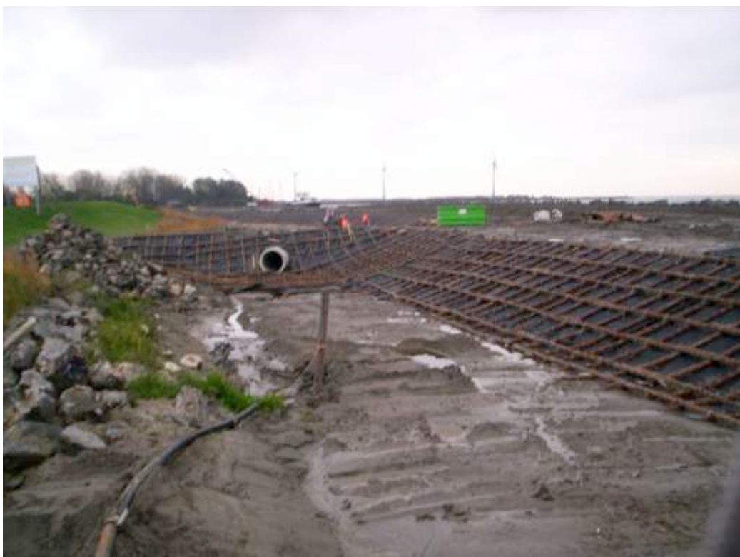
Afb. 5.95 Tussen de oude dijk en het nieuwe land moest een strook water komen. Dit water is op de foto een droge sloot - de afwerking een zinkstuk waarop stortsteen moet komen.
