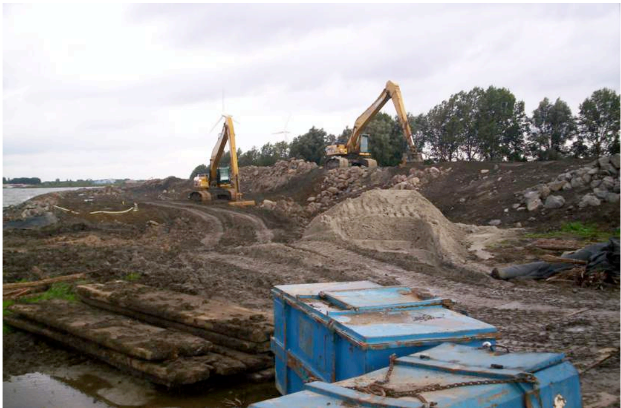
Afb. 5.33 Deze foto geeft een goed overzicht op welke manier met de historische noordse stenen werd omgegaan. Al deze stenen verdwenen in het water als stortsteen.
