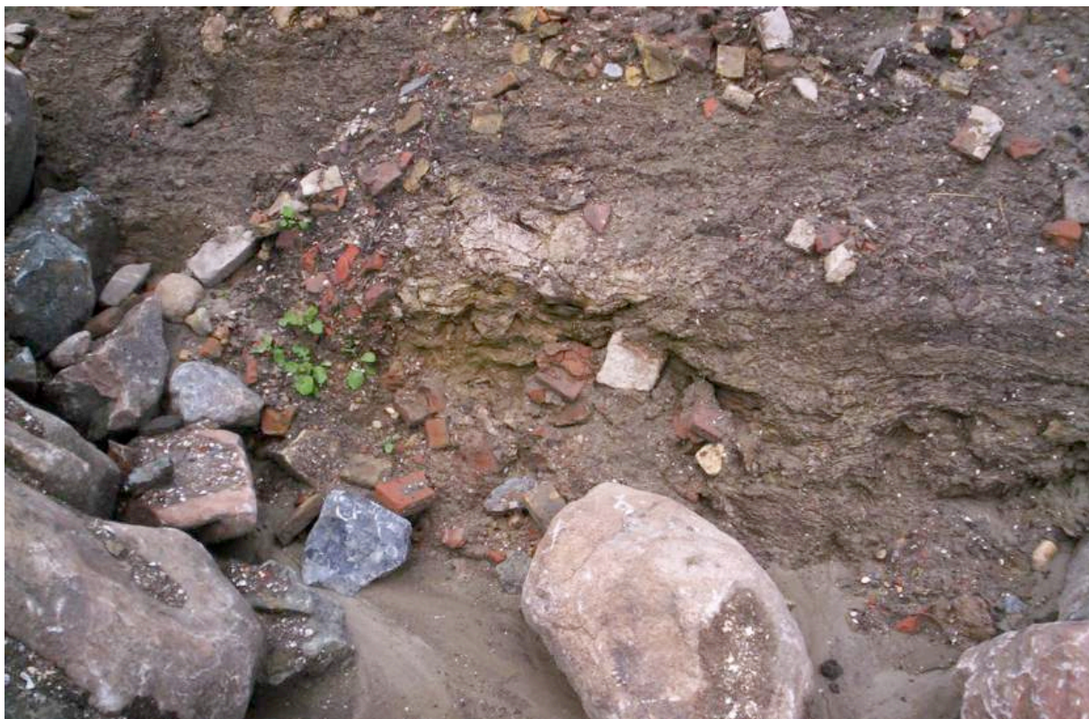
Afb. 5.27 Nadat het puin vanonder de glooiing was verdwenen, kwam het binnenste van de oude dijk te voorschijn. Er was geen wierdijk te vinden maar het wier was wel als ophogingsmateriaal gebruikt. Boven de ronde noordse steen is licht gekleurd zeewier te zien.
