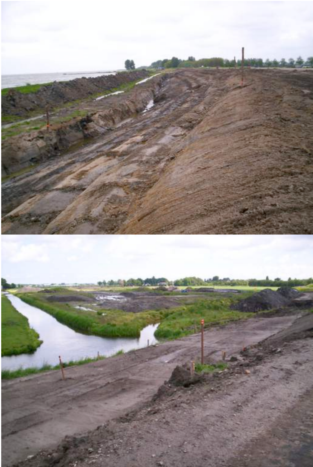
Afb. 5.77 Er was behoefte aan een opslagterrein. Eventueel kon men overgaan tot onteigening. De foto maakt laat zien dat ongeveer 5 ha grasland bij Oosterleek tussen de Leekerweg en de dijk, gehuurd is van een veehouder. Op de voorgrond is de eerste laag klei aangebracht voor de steunberm.
