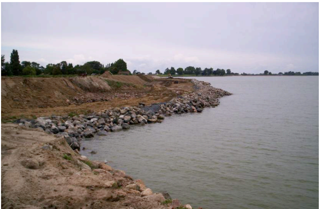
Afb. 5.40 De dijksloot werd vergraven en de klei in het natuurgebied opgeslagen. De aangevoerde grond werd met behulp van een bulldozer verwerkt en verdicht.
