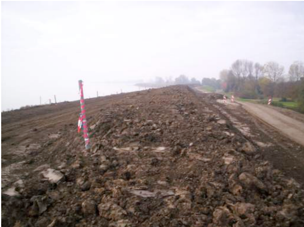
Afb. 5.92 De nieuwe dijk heeft hier al de vorm van een dijk. Dit was nodig omdat het stormseizoen in aantocht was.
