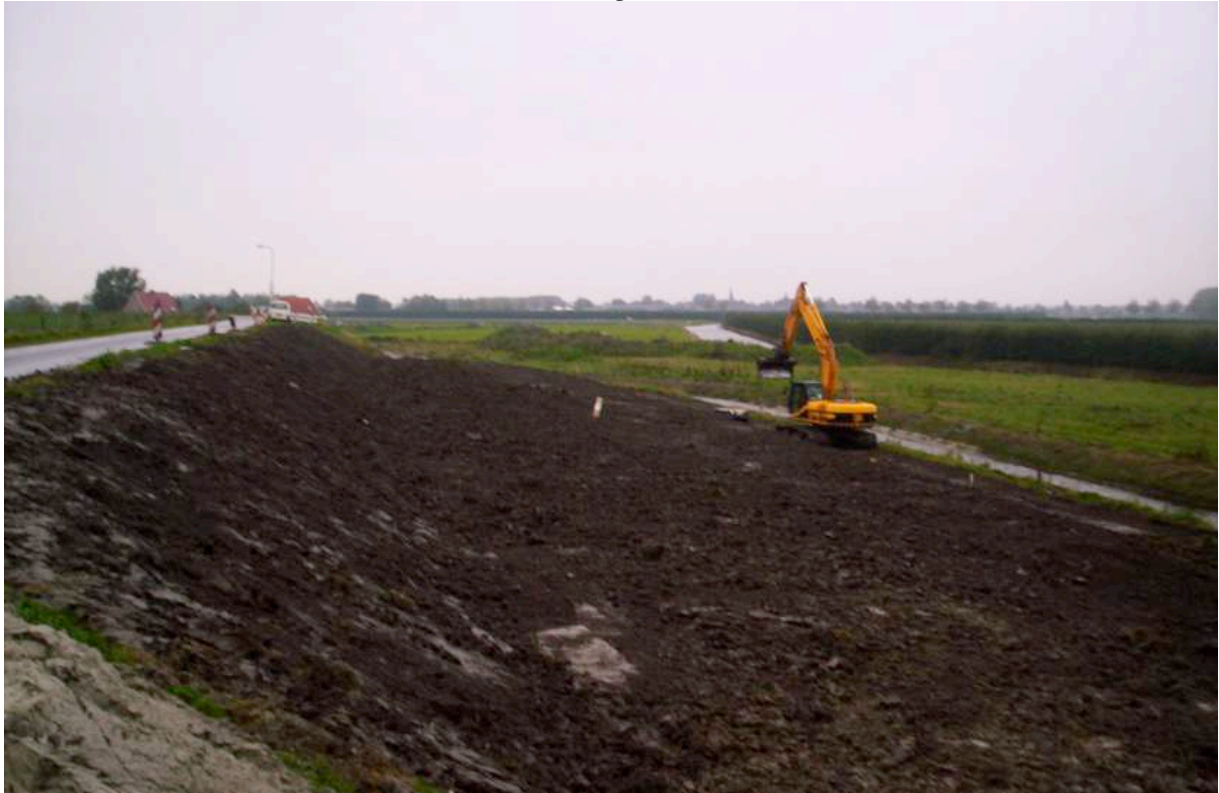
Afb. 5.57 Nabij het gemaal van de Drieban moest ook een steunberm worden aangebracht. Hier werd wel West-Friese klei toegepast. Andere aannemer - andere regels.
