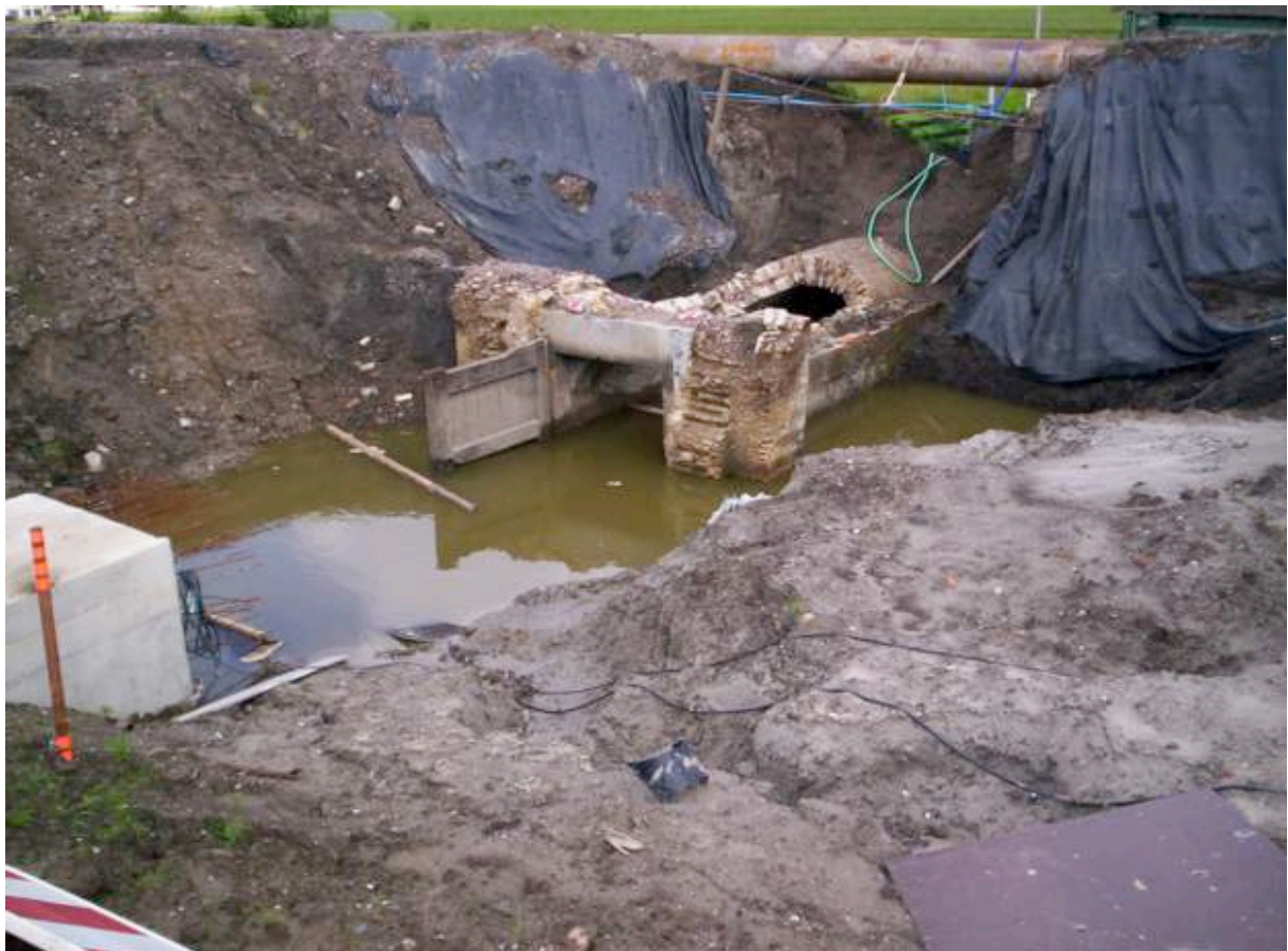
Afb. 5.60 Zo kwam de oude sluis in het voorjaar te voorschijn. In september 2008 was de voorkant, bestaande uit de stormschuif, een hardstenen geleiding van de oude stormschuif en de deurkas, verdwenen.
