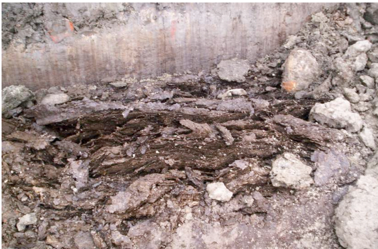
Afb. 5.28 Hier is een aanzienlijke laag zwart zeewier in de dijk verwerkt.
