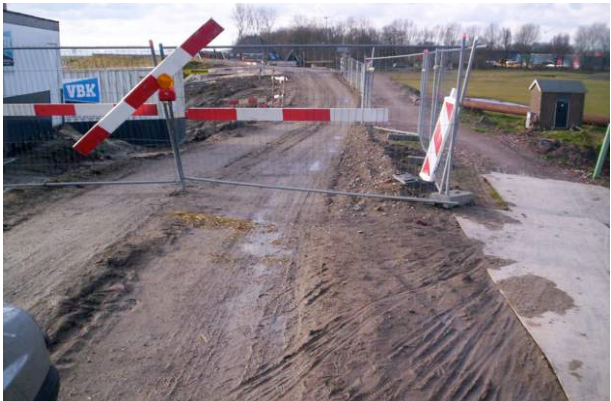
Afb. 5.59 De oude dijk was met ongeveer een meter verlaagd. Ook hieraan kleefden weer de nodige problemen.
