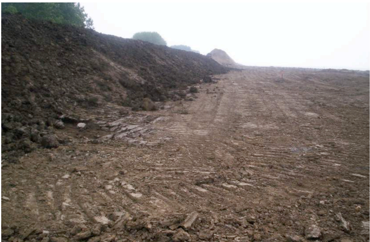
Afb. 5.42 Dit is de dijk bij het Leekervuurtje anno september 2008. Er is begonnen met het aanbrengen van de steunberm aan de binnenkant van de dijk.
