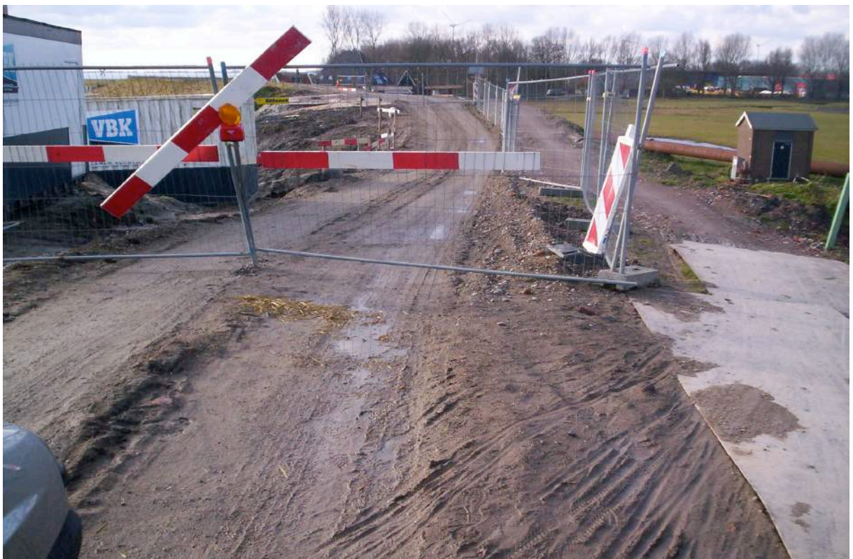
Afb. 5.51 Hier worden de betonpalen geheid voor de nieuwe betonnen koker. Om goed te kunnen werken is na de ontgraving ongeveer 1.00 m zand op de bodem gestort. Onder het zand lag een drainage voor de bemaling.
