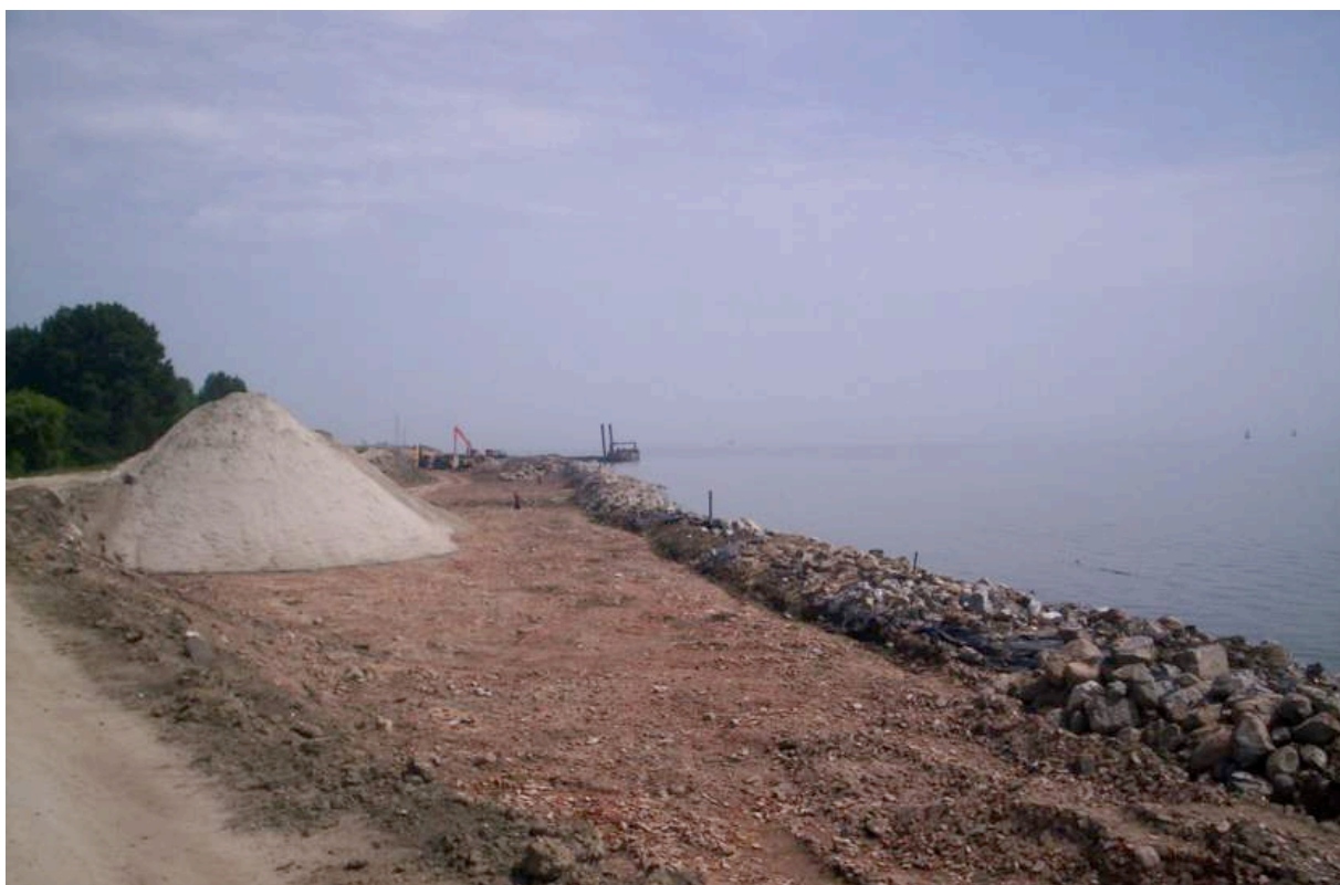
Afb. 5.12 De oude glooiing van noordse stenen was gezet op puin dat voornamelijk uit halve stenen bestond. Dit puin werd verspied over het zand en kapot gereden met de rupsen van een bulldozer. Puin stof bleef over. In het puin resteerden allerlei natuursteen elementen en stukken van oude tegeltjes. HHNK vond dit niet interessant genoeg om een archeoloog ernaar te laten kijken. Jammer.
