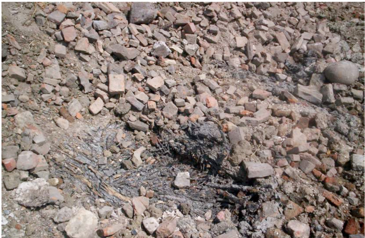
Afb. 5.17 Onder een dunne laag puin werden takken zichtbaar. Op de takken zullen voorheen noordse stenen hebben gelegen. De stenen moesten voorkomen dat de golven die tegen de wierdijk vastliepen, de grond voor de wierdijk zouden wegspoelen.
