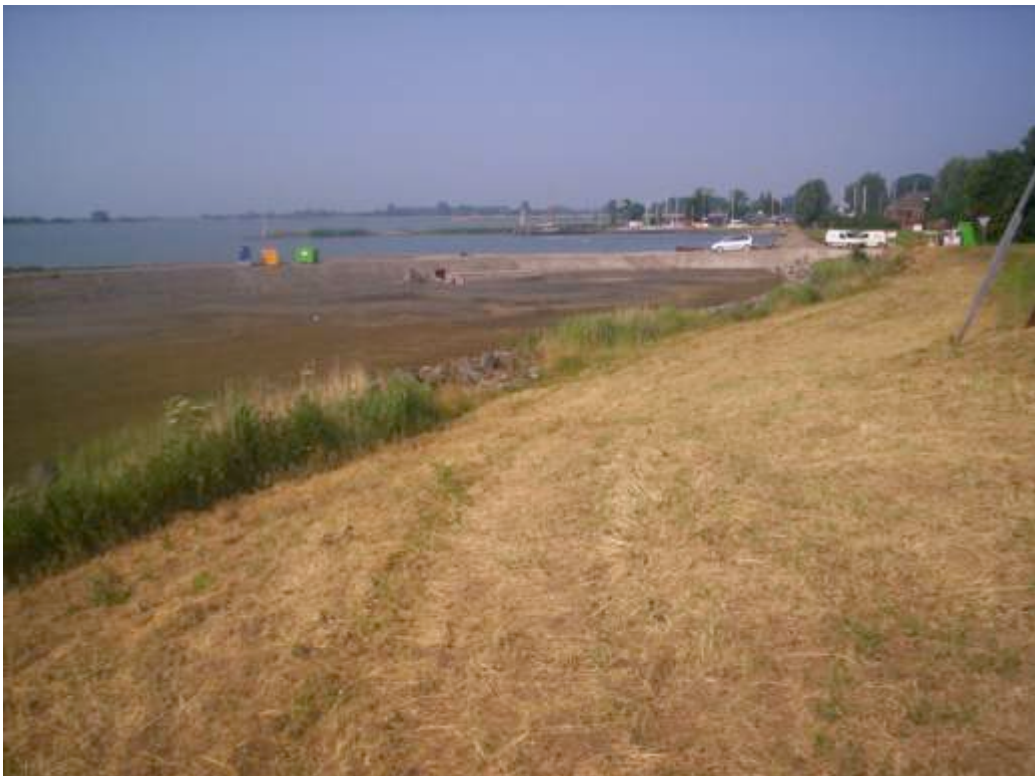
Afb. 5.93 Dit geeft het zicht op de vordering van de werkzaamheden ten oosten van de Broekerhaven. Hier moest buitendijks land worden aangelegd ter bescherming van de Zuiderdijk. Door middel van schanskorven met stortsteen was een nieuwe teen in het water gemaakt. Achter de schanskorven werd zand gespoten afkomstig van de jachthaven het Kreupeltje in Andijk. Dit was een wijziging van het bestek.
