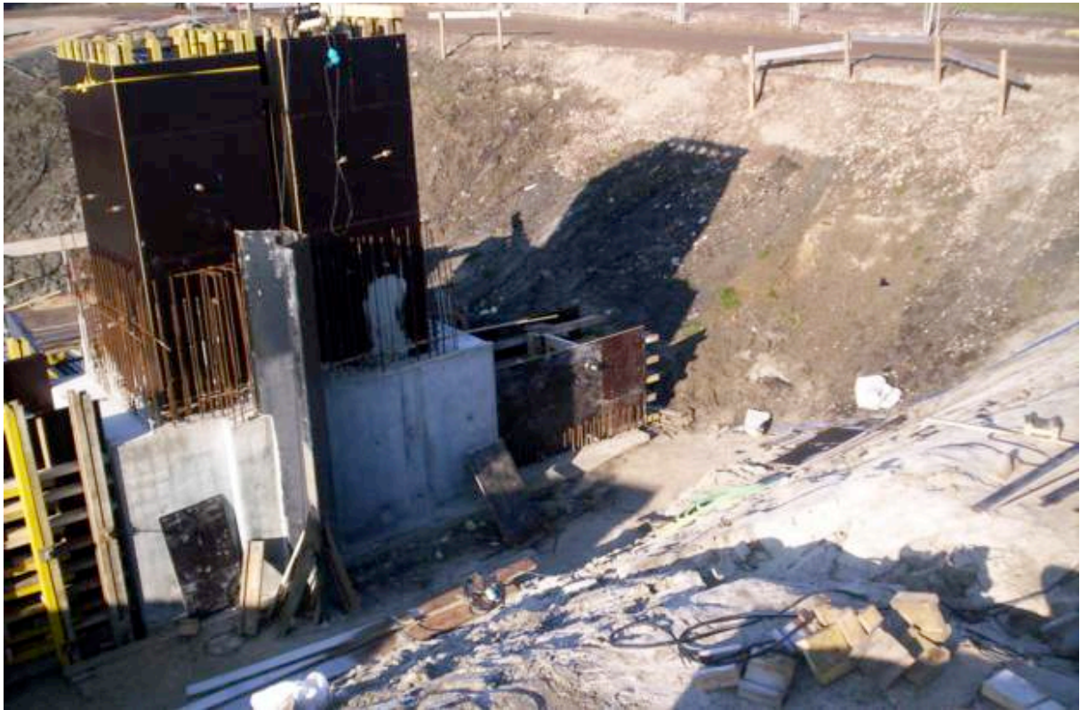
Afb. 5.58 De bouw van de schacht van de stormschuif in beeld. Onder de bekisting van het meest rechter gedeelte zijn stalen buizen geheid. Dit gaat later problemen opleveren.
