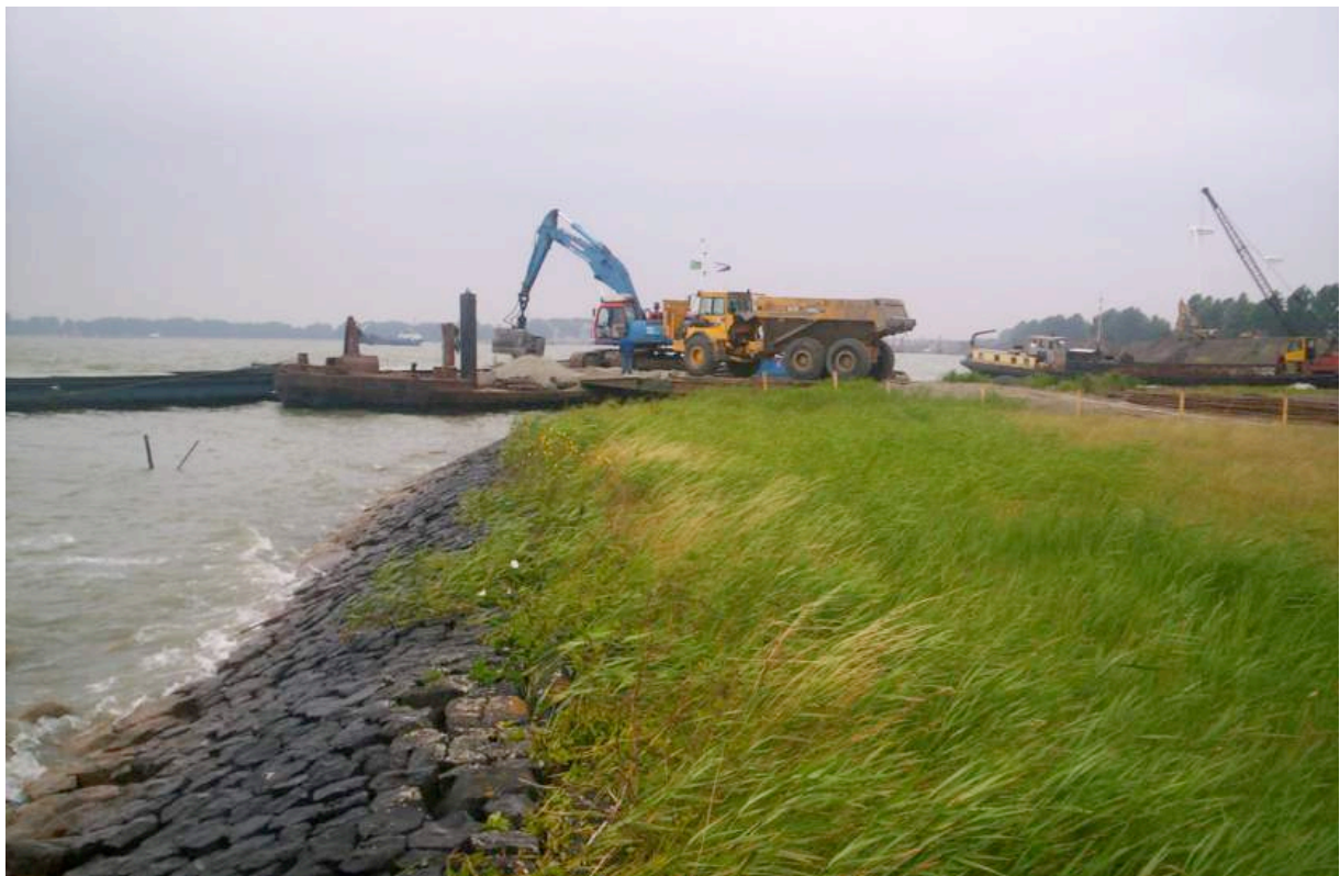
Afb. 5.30 Een overzicht van de losinrichting op de Kleine Uiterdijk. Voor de machine met knijperbak staat de chauffeur van de dumper. Rechts liggen de wiepen klaar om een zinkstuk te maken. Het oude vrachtscheepje wordt hier gebruikt om de zinkstukken naar het werk te varen.
