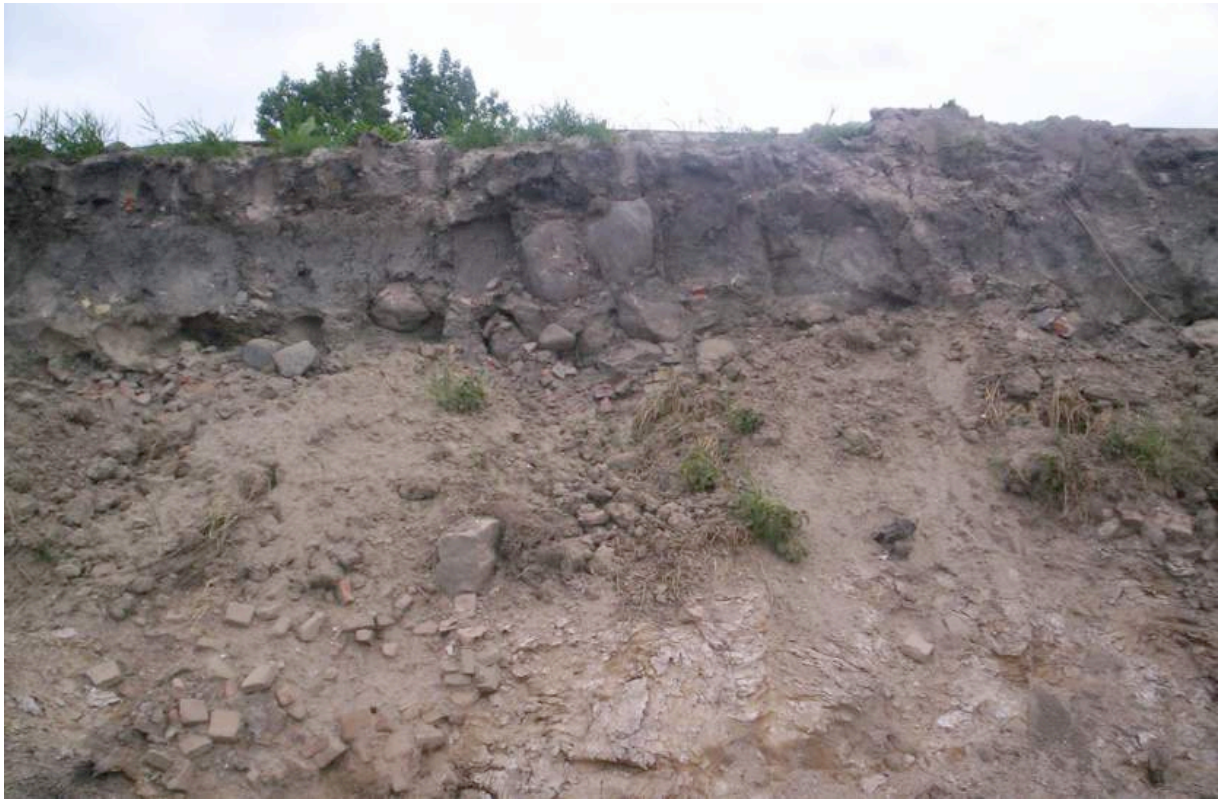
Afb. 5.21 Uit de foto hierboven blijkt dat een complete rij stenen als opslag in de dijk was begraven. Enkele stenen zijn blijven hangen maar van de meeste is de afdruk nog te zien. De opslag van de stenen kwam later ook te voorschijn bij de Weederhoek. Hier zijn de stenen onder de nieuwe weg begraven.
