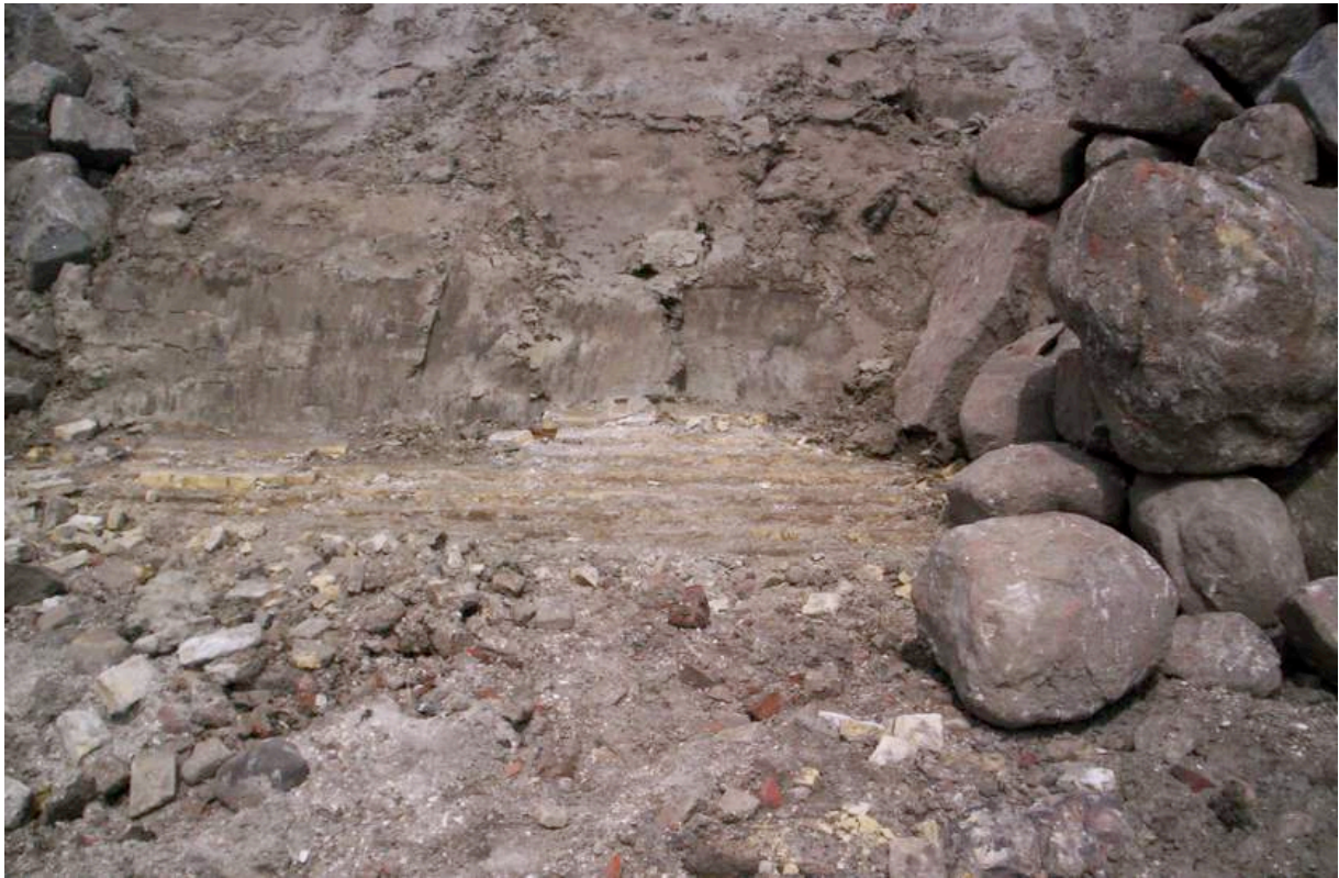
Afb. 5.15 Ongeveer 250 m. ten oosten van de Spuiter kwam dit beeld vrij vanonder de puin. Men had metselwerk voor de wierdijk aangebracht. Mogelijk een poging om de paalworm uit de palen te weren. Zie p. Ook dit detail is niet archeologisch onderzocht.
