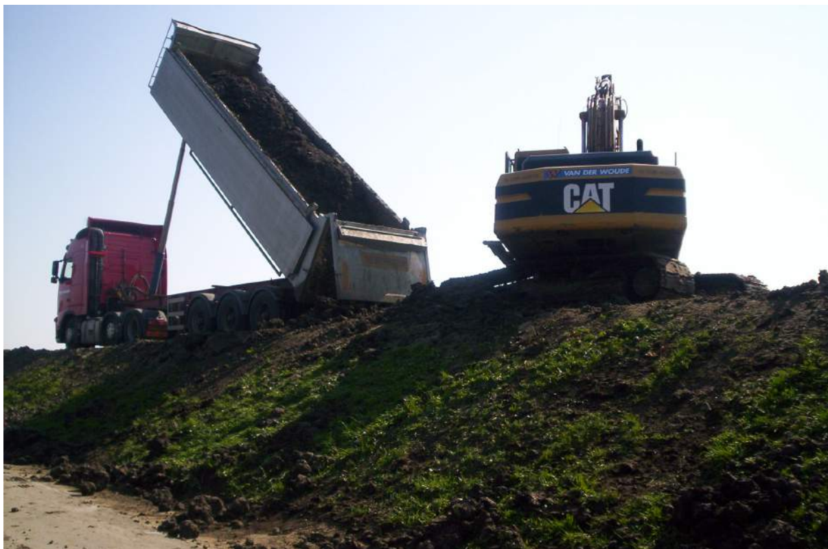
Afb. 5.4 Naast de oostelijke oprit bij De Weed lost een vrachtwagen zijn vracht op de weg. De kraan brengt de keileem onderaan de dijk bij het water.
