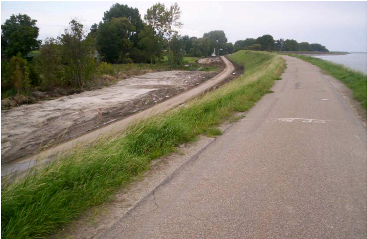
Afb. 5.47 Dit is een met zand gedempte kleiput bij De Weed. In de kleiput wordt de onderweg aangelegd. De kleiput is rond 1923/24 gegraven om de Zuiderdijk tot een hoogte van 4.00 + NAP te kunnen verhogen. Het veen dat in de kleiput was ontstaan was ongeveer 75 cm dik.
