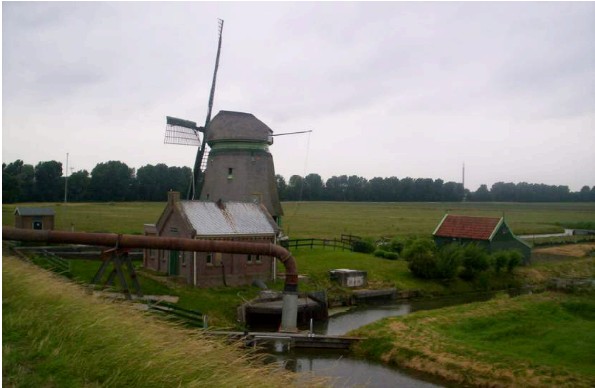
Afb. 5.35 Om de waterafvoer van water van een gedeelte van de polder Schellinkhout veilig te stellen, hing men een grote dompelpomp in het polderwater om het te veel aan water over/door de dijk te pompen.
