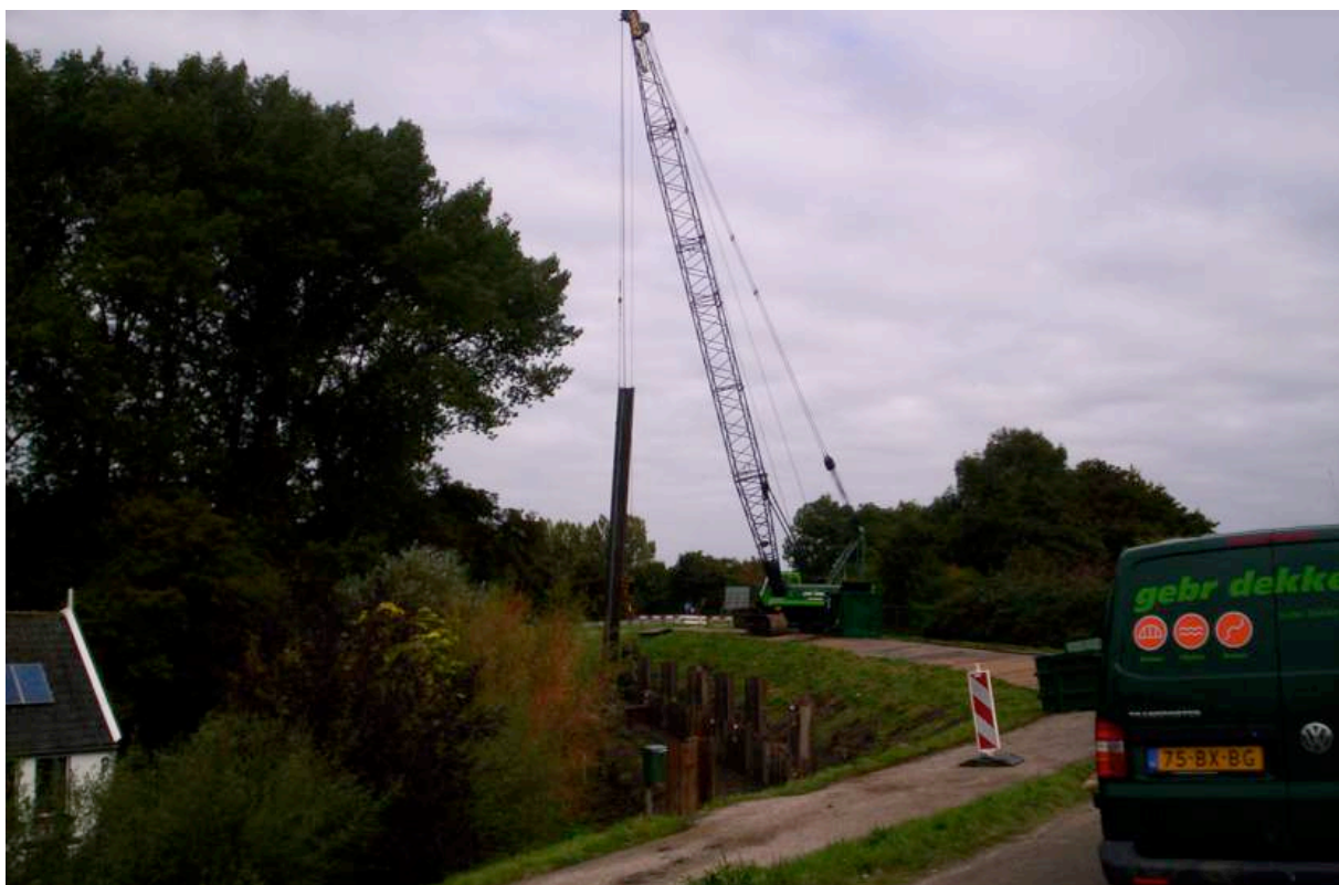
Afb. 5.55 Bij de toegang van de camping van Broekerhaven wordt aan de binnenkant van de dijk een damwand geheid. Dit vond men nodig omdat hier geen steunberm kon worden aangelegd. Het heien van een damwand geeft alleen schijnveiligheid. Uitleg hierover in hoofdstuk 7. Dit gedeelte van de versteviging van de Zuiderdijk werd uitgevoerd door de aannemer De Vries en Van de Wiel uit Schagen.
