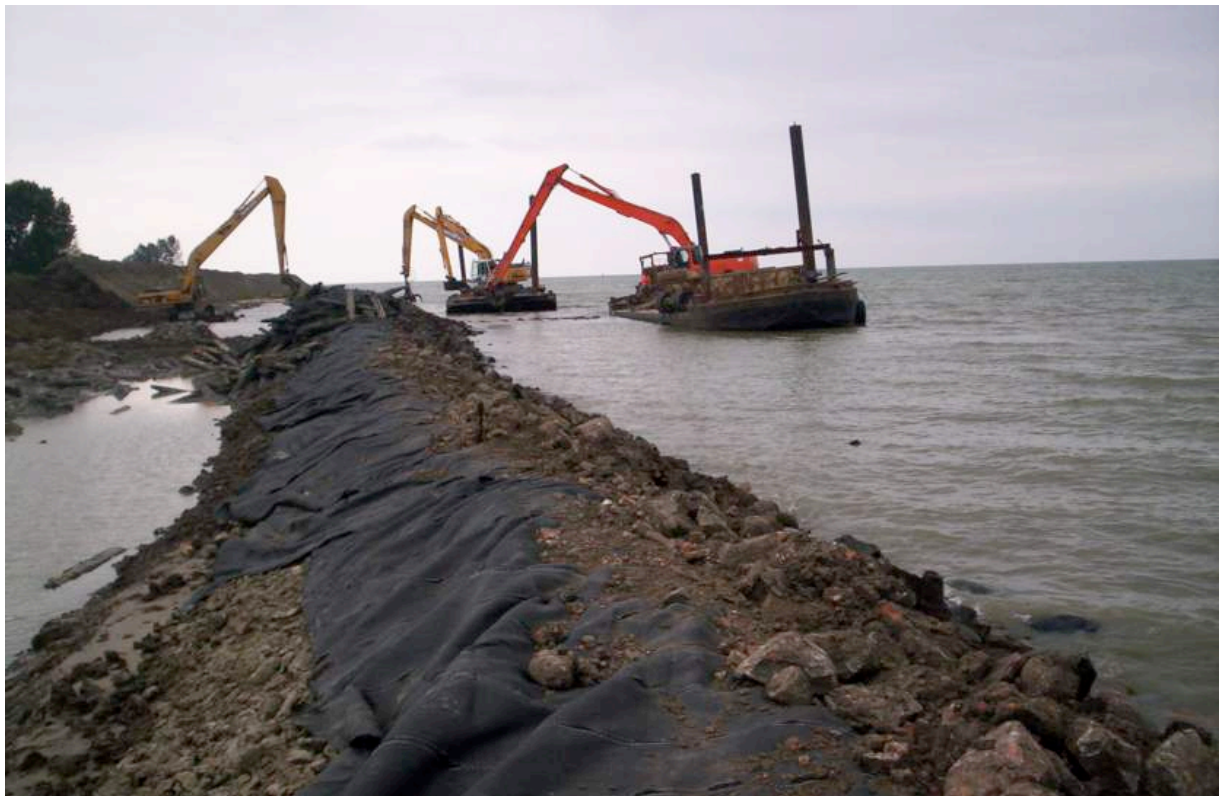
Afb. 5.8 Nogmaals het zicht op het werk maar nu is er een tweede ponton die het zinkstuk op zijn plaats moet leggen en vervolgens de noordse stenen uit de oude glooiing op het zinkstuk. De stortsteen wordt in een bak op het ponton meegenomen.
