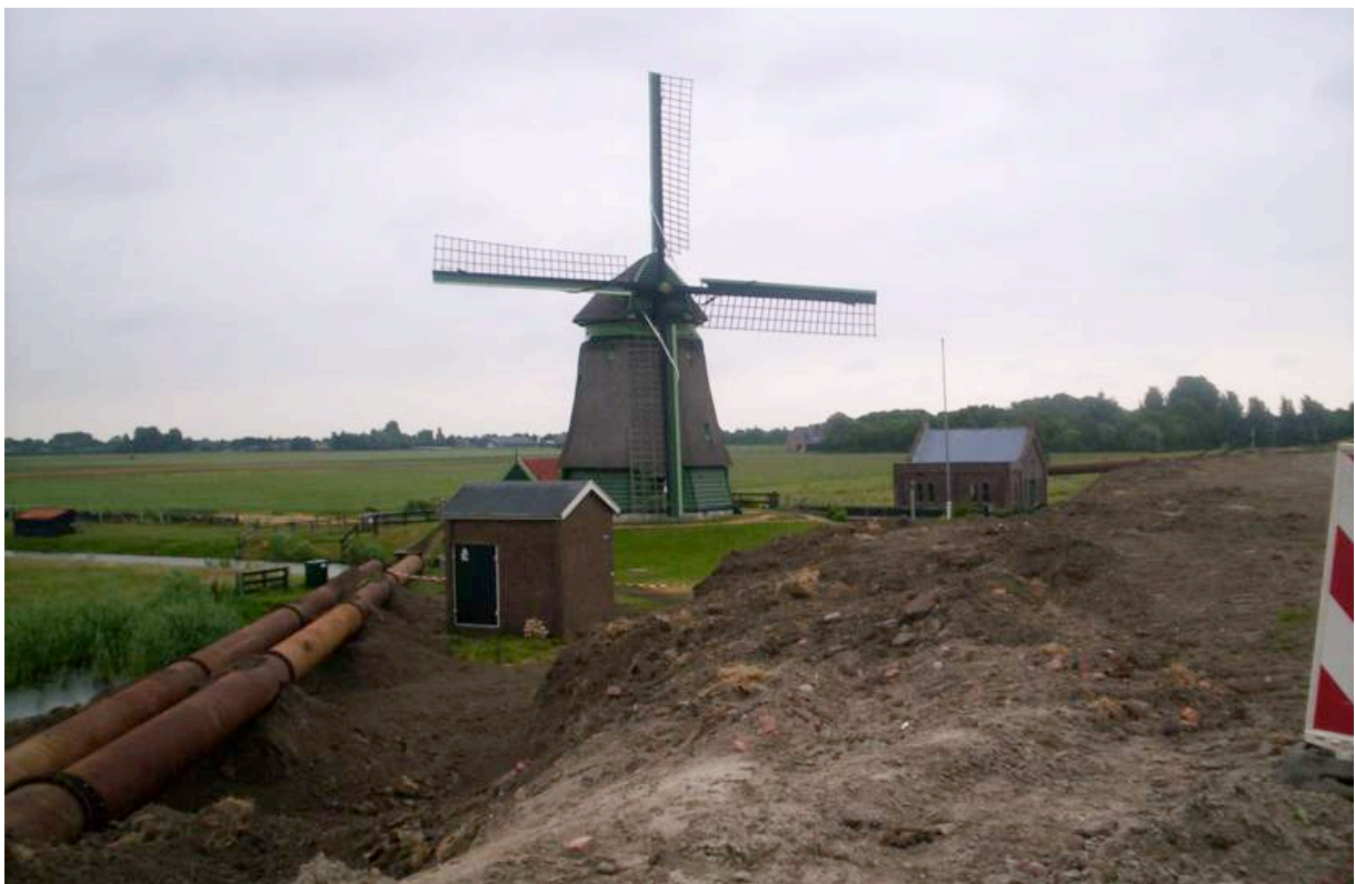
Afb. 5.36 Om water in de polder in te laten tijdens droge perioden werden twee buizen over/door de dijk gelegd. Met behulp van een vacuüm pomp regelde men het inlaten van water.
