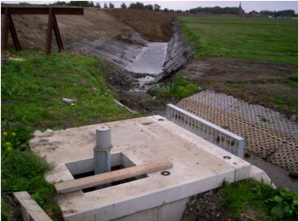
Afb. 5.73 Een duidelijk voorbeeld van slootje graven en weer dempen en weer graven. De put in het talud van de oude dijk is de waterdoorlaat van de Grote Uiterdijk naar de polder Schellinkhout. Op de voorgrond is de nieuwe bemalingsput van de Grote Uiterdijk te zien. Elektrisch, zonder een molentje, was aantrekkelijker geweest..
