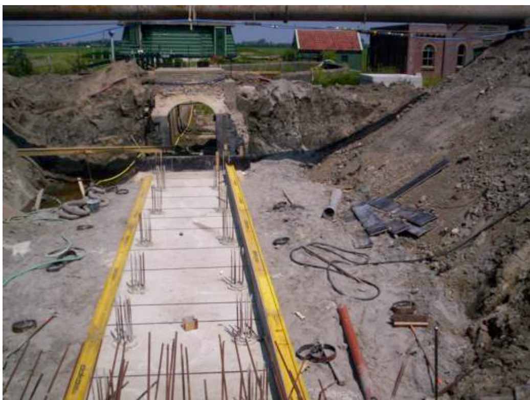
Afb. 5.66 Beeld van de werkvloer voor de nieuwe koker. De wapening steekt uit de buispalen voor de verbinding met de wapening van de koker. Er ontstonden problemen door het verlagen van het grondwater in de bouwput. Het water onder de molenkolk liep weg waardoor de muren van de kolk gingen scheuren en verzakken. Het oude gemaal, ook een rijksmonument, trof hetzelfde lot.
