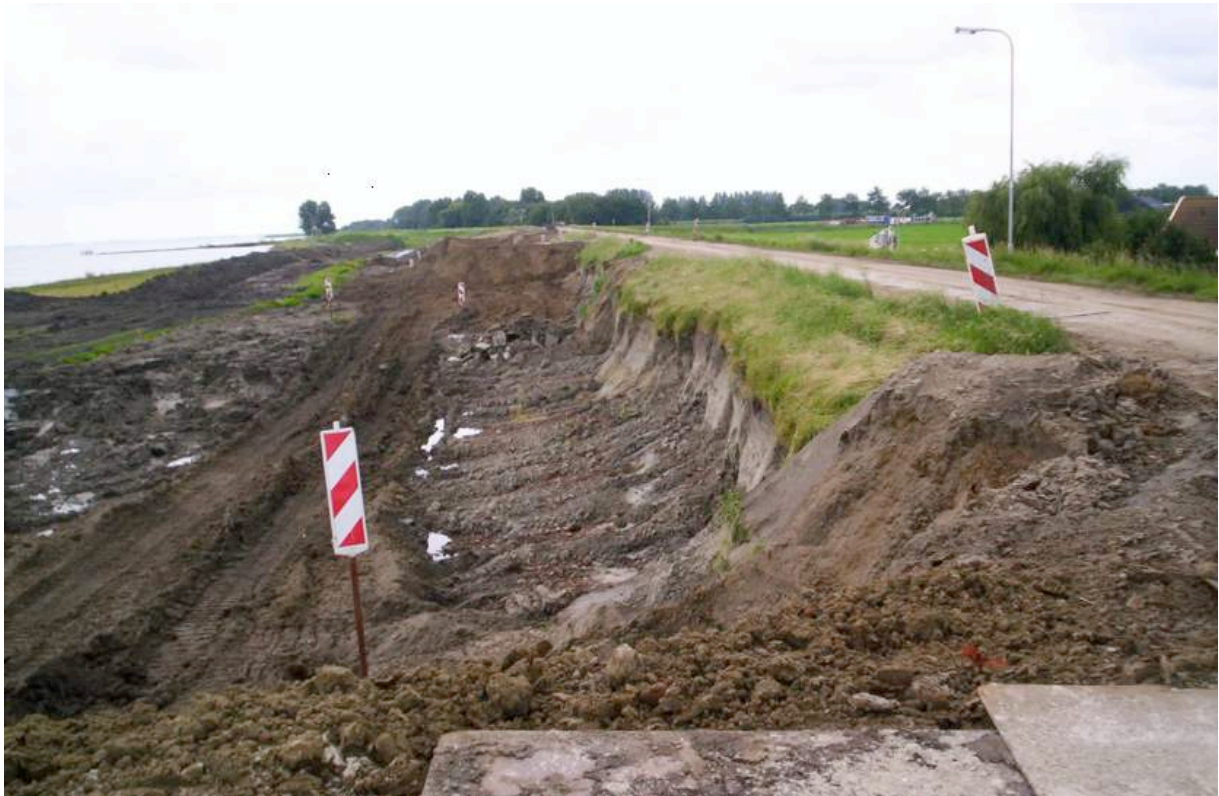
Afb. 5.39 Bij het buitendijks land van Wijdenes moest ook de dijk worden verschoven. Op de achtergrond is links het haventje van Wijdenes en de keten van de uitvoering. Het asfalt is hier nog als rijpad aanwezig.
