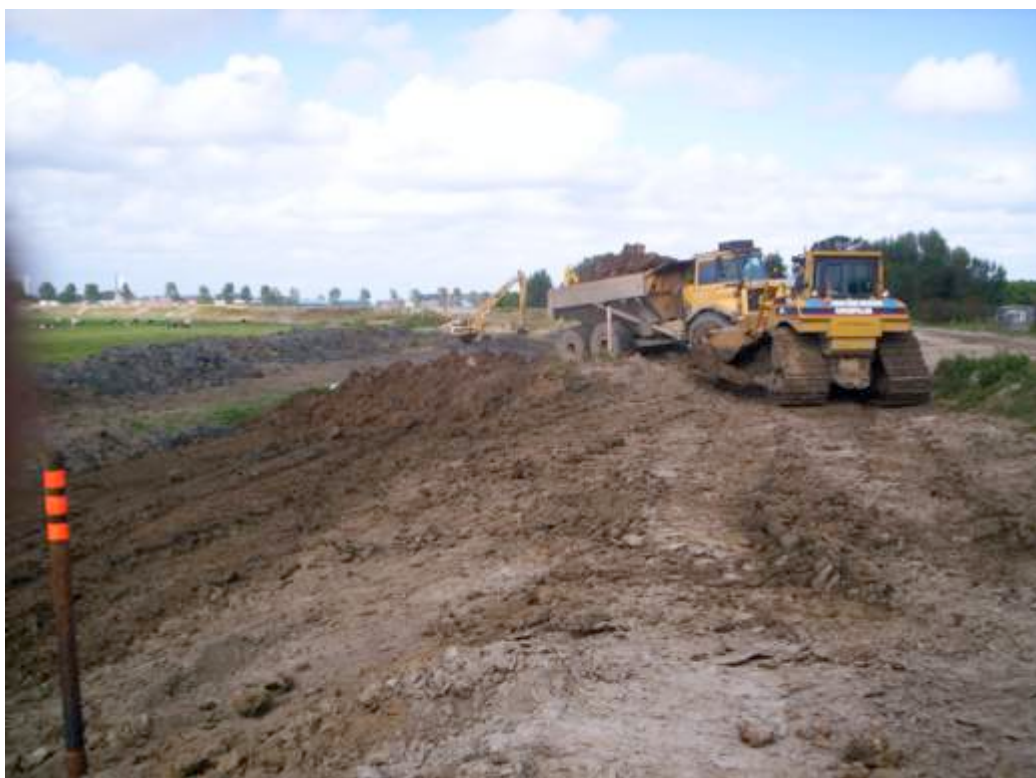
Afb. 5.72 Er wordt klei aangevoerd waarmee de bulldozer de sloot weer dichtschuift. Mogelijk voldoet de klei niet aan de “eisen”.
