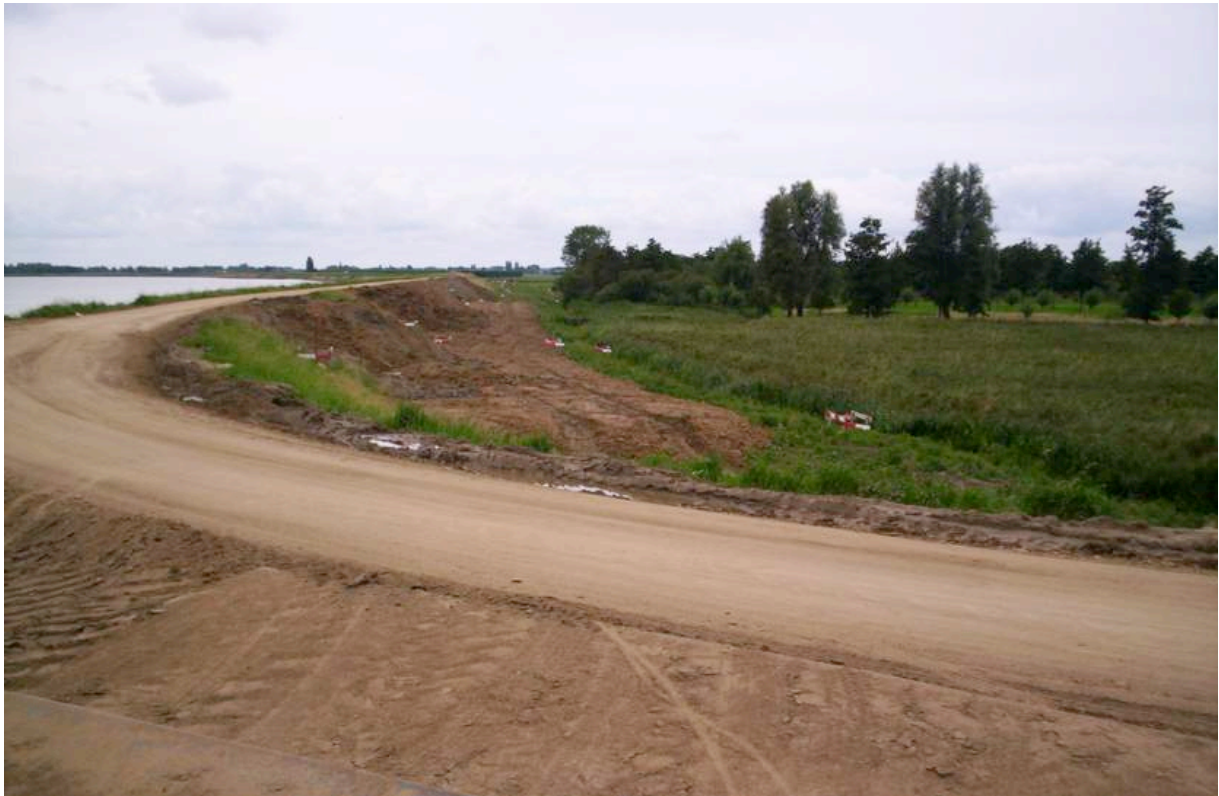
Afb. 5.41 Een beeld vanaf de losinrichting bij het Leekervuurtje in noordelijke richting, september 2008. De teen van de nieuwe dijk is klaar en de ruimte tussen de oude dijk en teen wordt opgevuld met klei.
