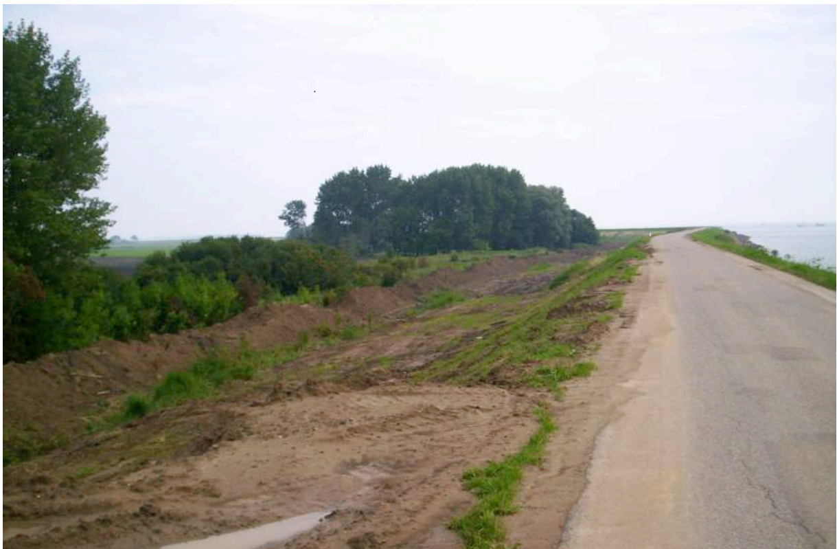
Afb. 5.48 Hier de eerste ophoging voor de steunberm in de richting van De Weederhoek. De teelaarde van de oude dijk is in de kleiput in depot gezet.
