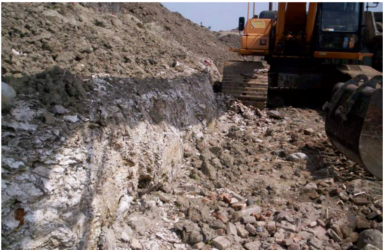
Afb. 5.16 Na het verwijderen van de puin kwam de wierdijk hier in volle omvang zichtbaar. Het was een muur van wier. De palen waren verdwenen.
