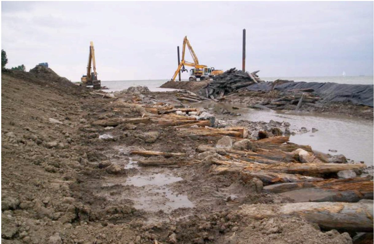
Afb. 5.6 De linkse graafmachine schept de keileem in het water. De voorste graafmachine op de ponton maakt van de keileem een dijkje, en de achterste graafmachine trekt de palen uit de grond. De palen hadden een doorsnede van 30 cm en waren 2.80 m lang. Op de voorgrond het pad van de graafmachine.
