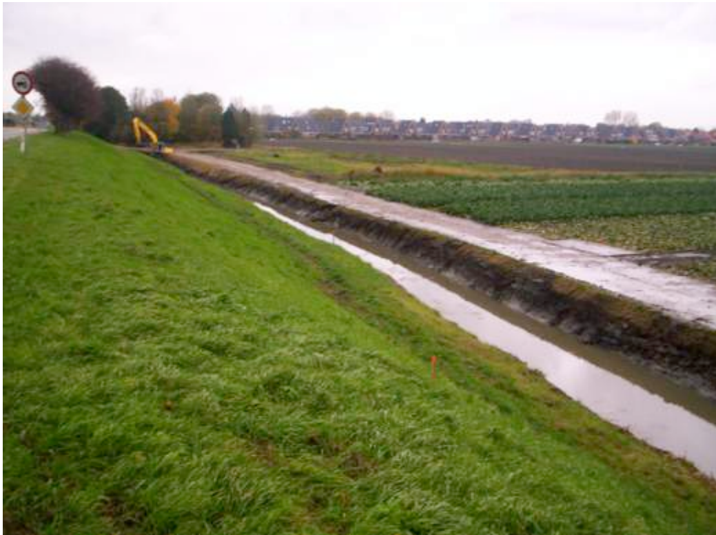
Afb. 5.96 Aan de binnenkant van de dijk moest een steunberm worden aangebracht. Dus als eerste is de dijksloot gebaggerd. De bagger is via de rijplaten met vrachtwagens afgevoerd.
