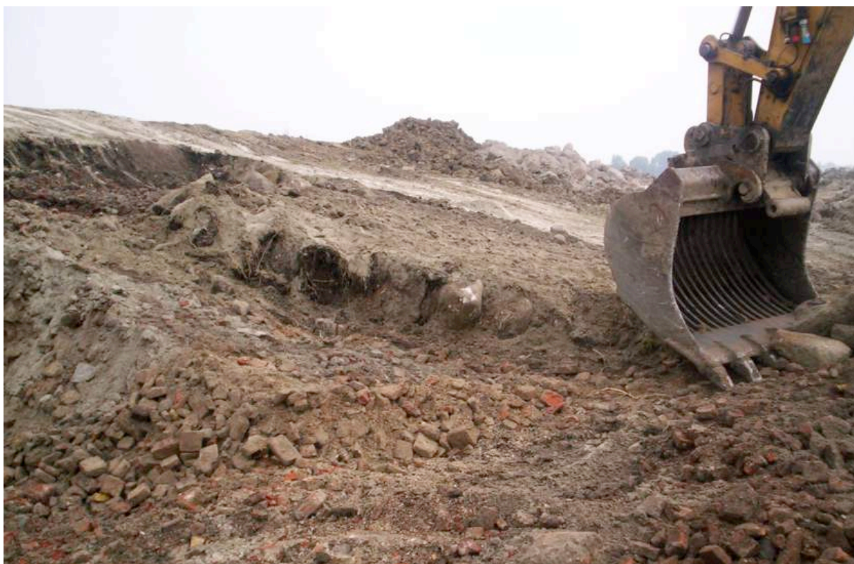
Afb. 5.26 Ook bij de glooiing van Oosterleek kwam een grote hoeveelheid puin tevoorschijn, voornamelijk halve metselstenen.
