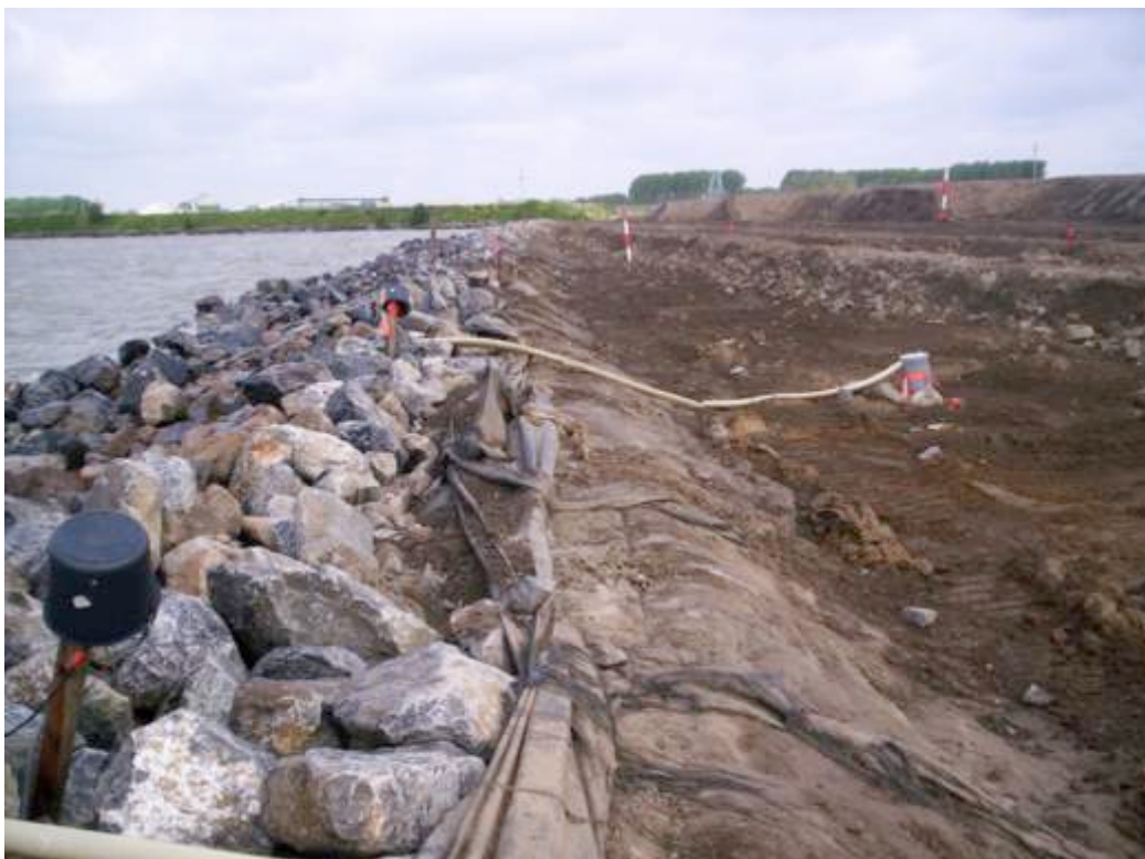
Afb. 5.69 In het voorjaar 2009 was het werk tot deze fase gevorderd. De teen van de nieuwe dijk was wind bestendig en de eerste ophoging van klei voor de oude dijk aangebracht. Het opgeperste water uit de diepe ondergrond werd door de pomp afgevoerd.
