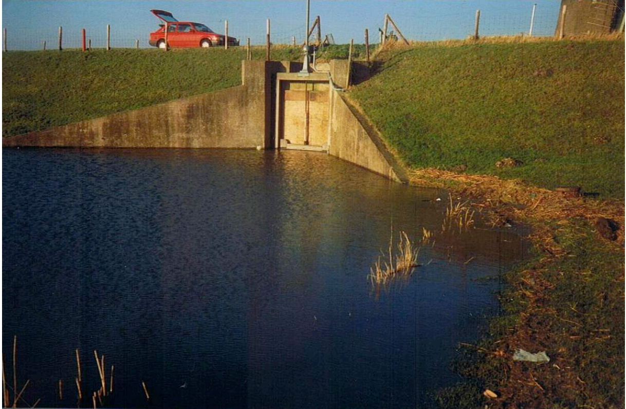
Afb. 5.49 Dit is de stormschuif van de molenuitlaat van de molen van Schellinkhout. Zonder aanwezigheid van een archeoloog heeft men de stormschuif met de deurkas van het vloeddeurtje in de gemetselde koker totaal gesloopt. Op de plaats van het water kwam een nieuwe betonnen koker, omdat de dijk hier veel breder moest worden.
