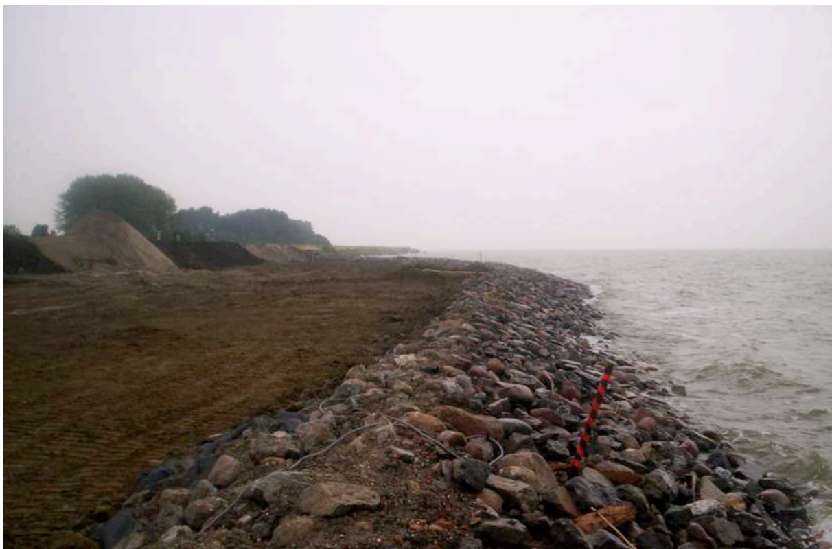
Afb. 5.43 De Weed, september 2008. De wierdijk is weer afgedekt. De voet van de nieuwe dijk is met de eerste lagen klei opgevuld en met de bulldozer verdicht. Volgens de uitvoerder was de bovenlaag van het wier tot stof vergaan. Nu noemt men dat composteren.
