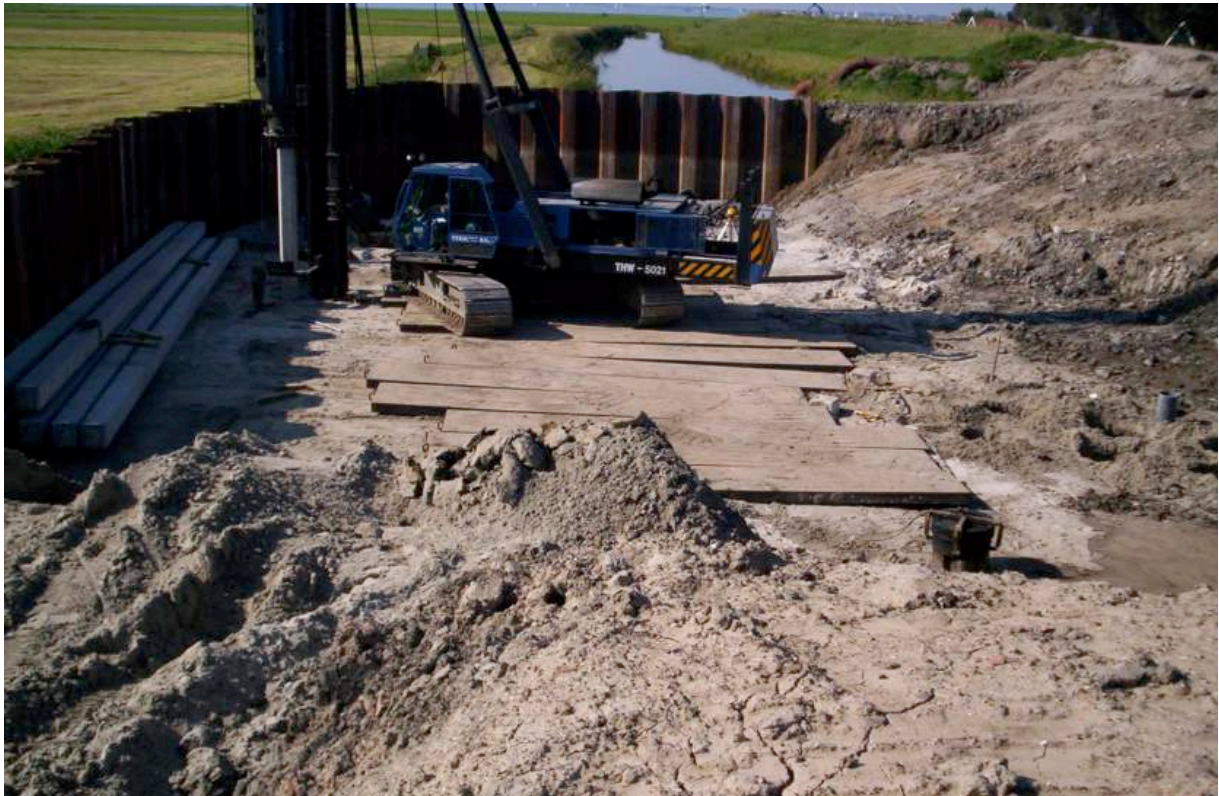
Afb. 5.50 Dit is het begin van de bouwput. Een stalendamwand is in de grond geslagen om de bouwput te kunnen ontgraven. De aannemer voor de bouw van de nieuwe koker was VBK uit Hoorn. Het grondwerk werd door de aannemer van de dijk, de firma Ploegam, uitgevoerd.
