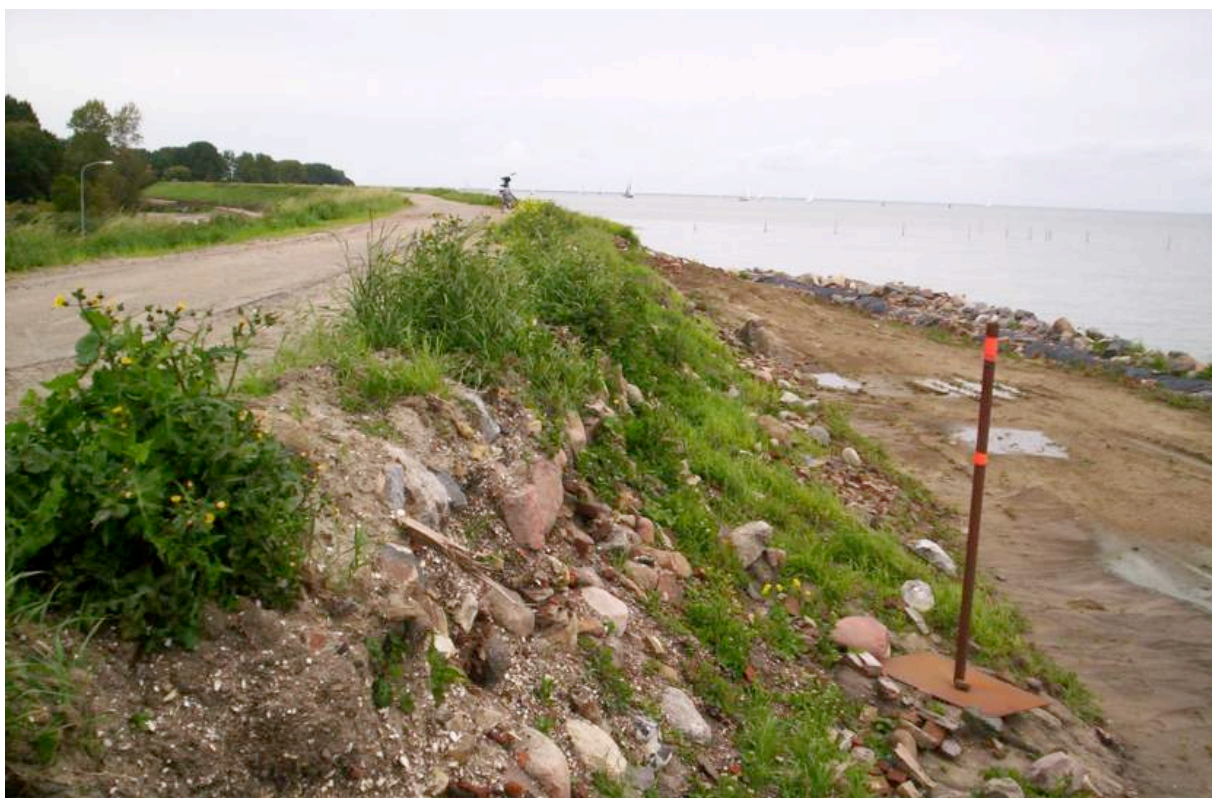
Afb. 5.44 Zicht op de voet van de nieuwe dijk in de richting van De Weederhoek. Op de voorgrond staat in de stortsteen een zogenaamd zakbaken en liggen schoongespoelde noordse stenen in kleuren van rood tot zwart.
