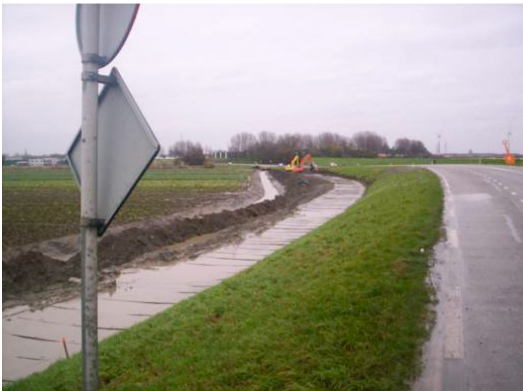
Afb. 5.97 De oude sloot is met klei uit de nieuwe sloot aangevuld en via de rijplaten wordt de restende klei aangevoerd. Rivierklei kwam hier niet aan te pas om als grond in de dijk te verwerken. Hier werd geen bulldozer gebruikt om de klei te verdichten.
