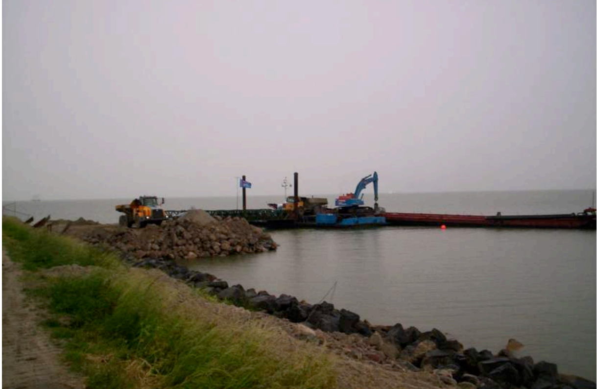
Afb. 5.5 Zo construeerde men bij het Leekervuurtje een loswal. Men maakte een rijweg naar een brug door noordse stenen in het water te storten. De brug rustt aan de andere kant op een groot ponton met daarop een hydraulische kraan om de keileem uit het schip te scheppen en in de laadbak van een dumper te storten.
