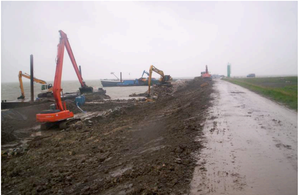
Afb. 5.24 Hier is al het materieel voor het maken van de nieuwe teen. Op de achtergrond een schip met keileem dat gelost wordt door een graafmachine met een grote knijperbak die de keileem in een dumper stort. Op de voorgrond het samenspel van machines. De voorste machine brengt de noordse stenen uit de glooiing op het zinkstuk.
