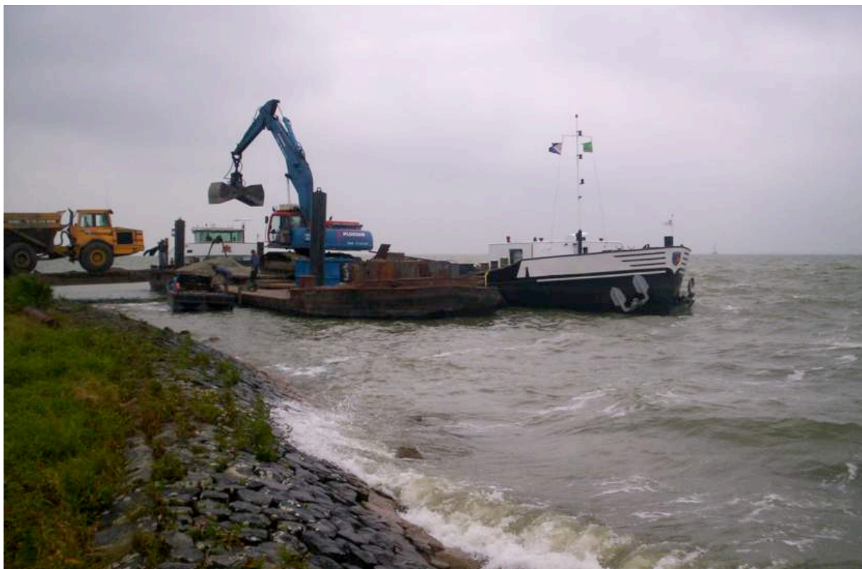
Afb. 5.29 Een overzicht van de losinrichting bij het Leekervuurtje. De man naast de machine op het ponton is nietig in verhouding tot het materieel.
