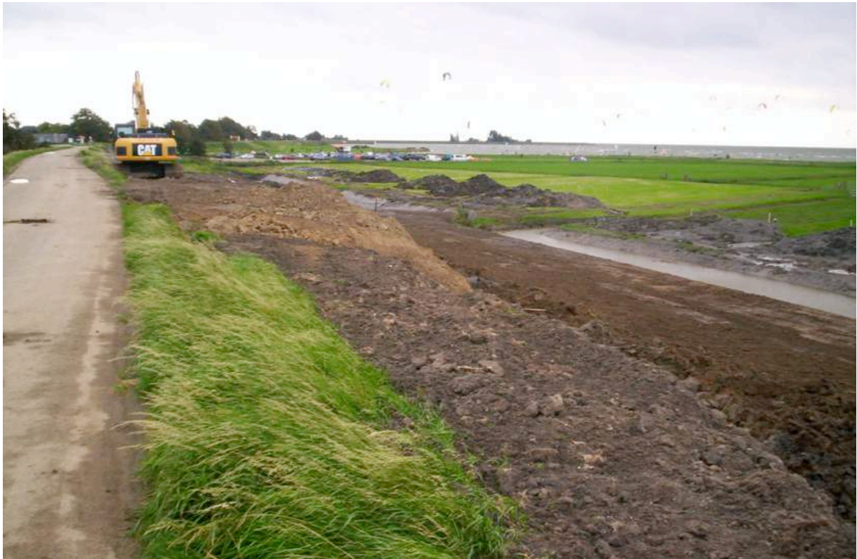
Afb. 5.37 Tussen de Meeweg en De Laan moest de dijk verschuiven naar het buitendijksland. Hier het begin van deze werkzaamheden. De sloot is opnieuw gegraven en de klei op het natuurgebied gestort.
