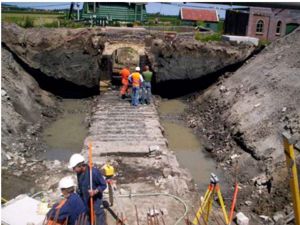
Afb. 5.65 Dit geeft een beeld van de fundering van de oude sluis. Het waren eikenhouten balken met een doorsnede van 16 x 31 cm. Dendrologisch onderzoek bevestigde de ouderdom van de sluis. De bomen waren rond 1592 gekapt in Denemarken. Ter plaatse zijn de balken met een trekzaag op maat gezaagd.
